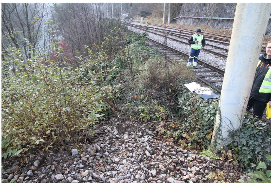
Levo od podpornega zidu je »teren« celo višji kot na progi
